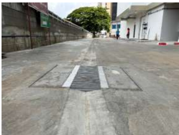
รูปที่ 2.1-48 รางระบายน้ำของโครงการ
