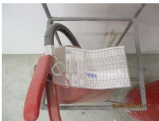
รูปที่ 2.1-10 ป้ายตรวจสอบ ป้ายแสดงวิธีการใช้งาน พร้อมการตรวจระดับเพลิงภายในพื้นที่ก่อสร้างของโครงการ
